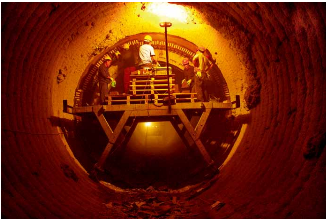
专业化水泥总包施工队伍为业主提供筑炉服务
