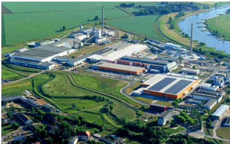
收购的德国Avancis公司薄膜太阳能工厂
