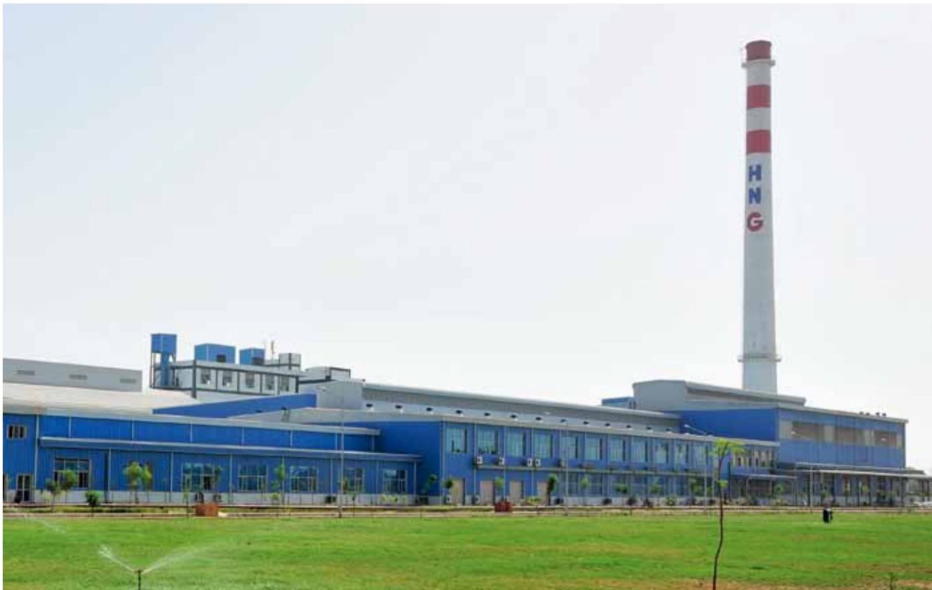
凭借先进技术, 承建海外玻璃工程
