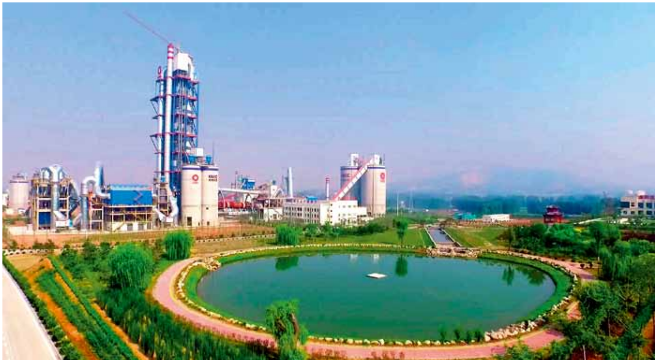
世界领先的低能耗、环保示范生产线
