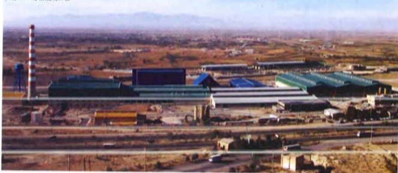
伊朗 AZAR 浮法玻璃工程
