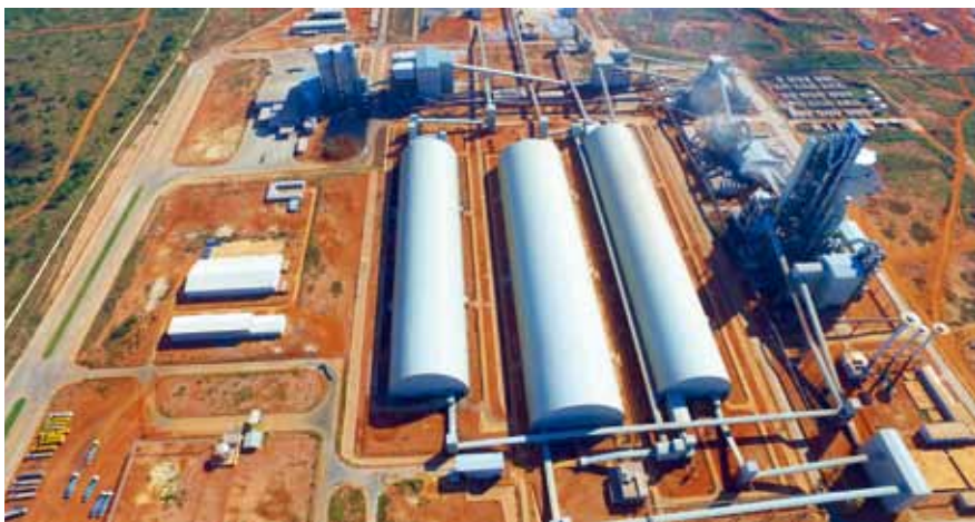
苏州中材坦桑项目全景图
