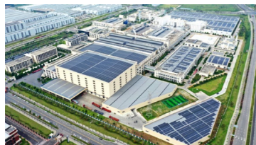
巨石成都利用厂区屋面，建成成都目前单体装机容量最大的分布式光伏电站
