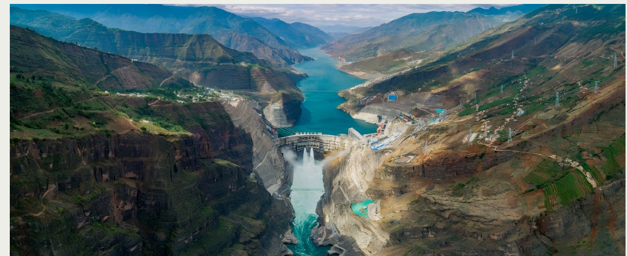
低热水泥构筑起白鹤滩无缝大坝
