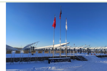
国检集团漠河极寒测试产业园
